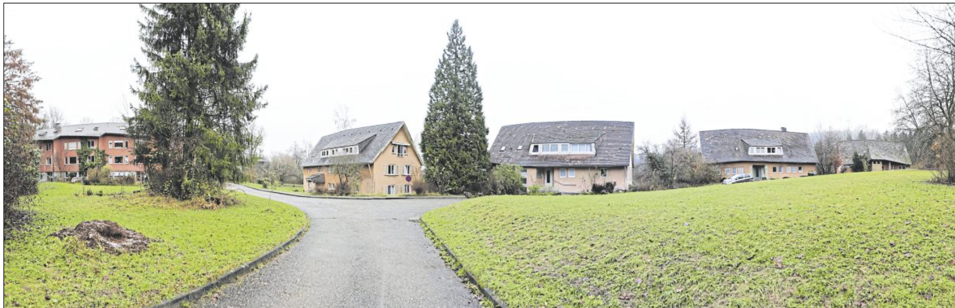
Die Häuser in der Siedlung im Gebiet „Im Steinbruch“ stehen seit den 1960er Jahren dort, sie sollen nun abgebrochen werden und Platz für neue Mehrfamilienhäuser schaffen.
